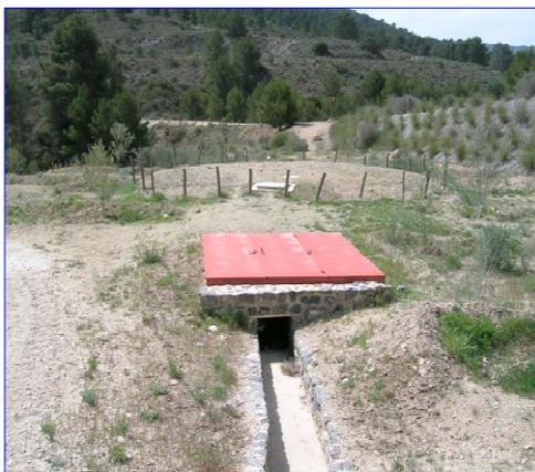
Detalle de la conducción de recogida agua, decantador y al fondo un depósito subterráneo.
