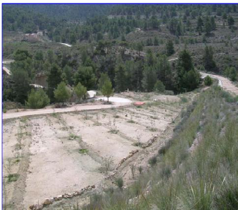
Superficie arcillosa compactada, con caballones y una ligera pendiente para conducir el agua a una cuneta de recogida, decantador y depósito subterráneo.
