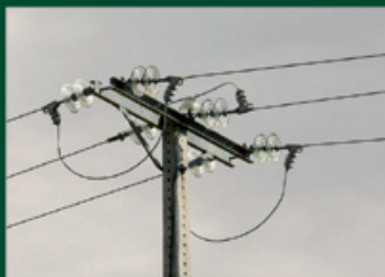
Aumento de la longitud de la cadena de suspensión a 1 metro, incremento del número de platos
