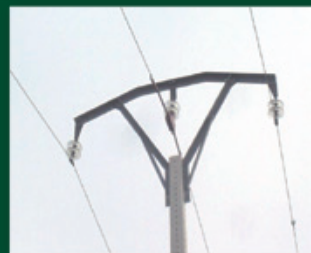
Aislamiento de la grapa central y del conductor central 1 metro a cada lado de la grapa
