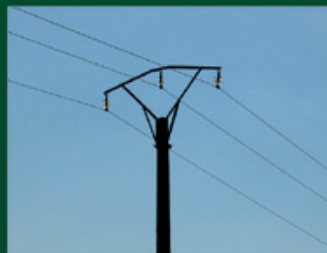
Aislamiento de la grapa central y del conductor central 1 metro a cada lado de la grapa
