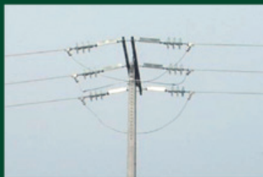
Aumento de la longitud de la cadena de suspensión a 1 metro, incremento del número de platos
