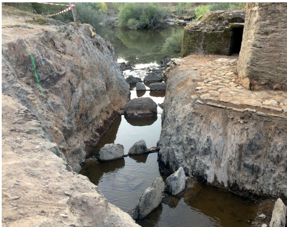
Rampa para paso piscícola ejecutada en el río Yeltes, “Molino El Rubio”, Término municipal de Villares de Yeltes (Salamanca)
