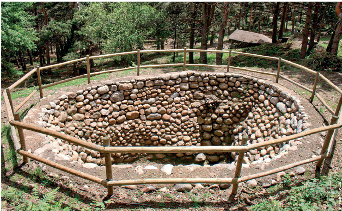
Pozo de nieve rehabilitado en La Rioja.
