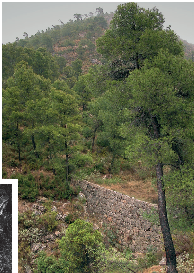
Antiguo dique de mampostería en el barranco de Vite. Sierra Ricote
