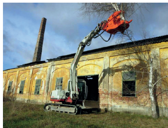
Desmonte controlado de un árbol con cizalla Westtech sobre excavadora en la proximidad de una nave
