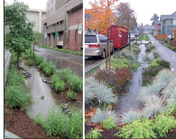
Fig. 2. Imágenes de jardines de lluvia para reducir la escorrentía. Izquierda: SUNY College of Environmental Science and Forestry, Syracuse, NY (Fuente: DASonnenfeld). Derecha: jardín de lluvia en Seattle, WA (Fuente: USEPA Environmental-Protection-Agency).
