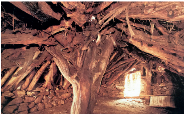
Detalle de la estructura central de la techumbre de un chozón sabinero de planta circular. Poste central, vigas, cabrios y ripias sobre la cual se coloca la "sarda" que impide el paso del agua
